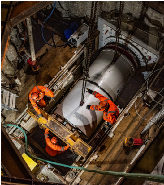
Blick auf die final eingebrachte Vortriebsmaschine
