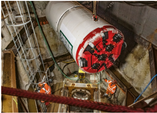
Einbringen der Vortriebsmaschine in die Baugrube
